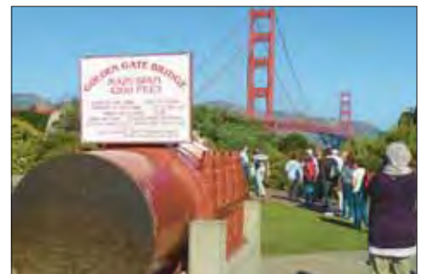
So dick sind die Kabel der Golden Gate Bridge in San Francisco.
